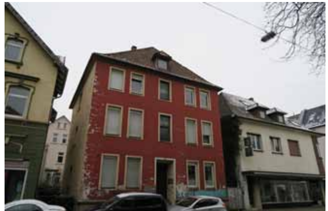
Abb. 100: Fassade südliche August-Bebel-Straße
