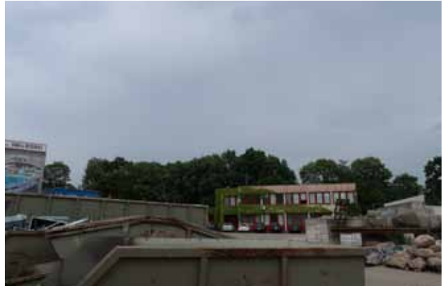
Abb. 85: Potenzialfläche nördlich Containerbahnhof
