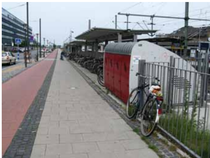
Foto 1: Abstellanlagen am „Neuen Bahnhofsviertel“
